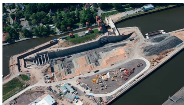
Schleusenanlage mit neuer Schleuse
