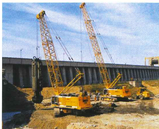
1,2 m dicke Schlitzwand für die Schleuse Uelzen, 1999
