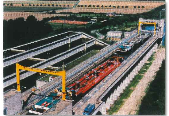
Die bestehende Schleuse Uelzen I besitzt eine Nutzlänge von 185 m, die von Schiffen, mit einer Breite bis zu 11,40 m passiert werden können.
