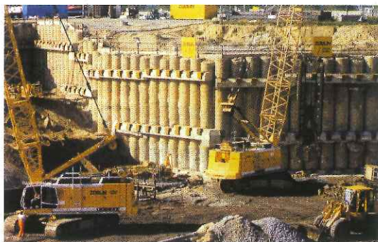
Bohrpfahlwand - Schleuse Uelzen, 1999
