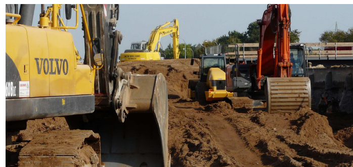
Bodenabtrag im Bereich der neuen Schleuse
