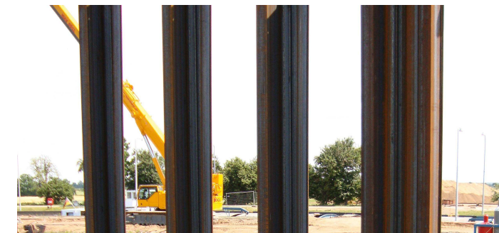
Baufeldberäumung und erste Rammarbeiten
