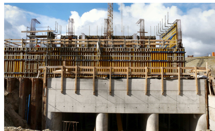
Bau des neuen Pumpwerkes
