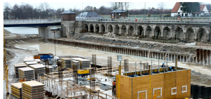
Einfahrtsbereich neue Schleuse, Pumpwerk im Bau
