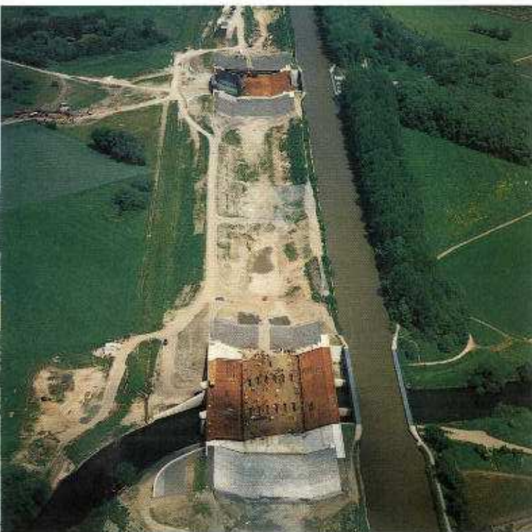
Die montierten Stahlteile der beiden Kanalbrücken
