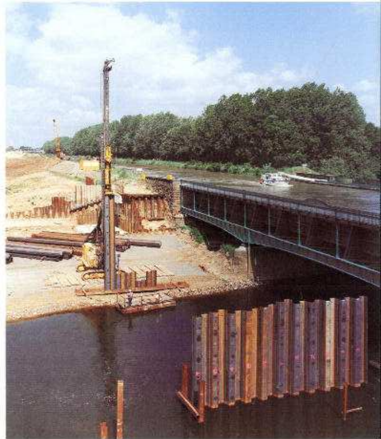
Rammarbeiten für die Strombrücke
