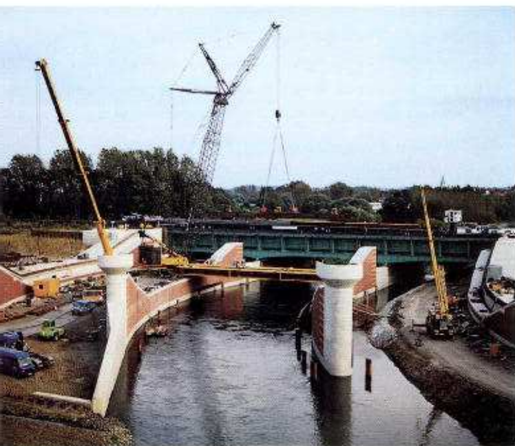
Umschlag der Stahlteile an der Br. 252
