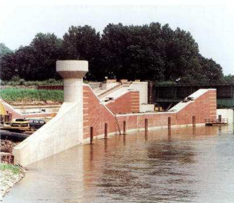
Östlicher Strombrückenpfeiler und Leitwand
