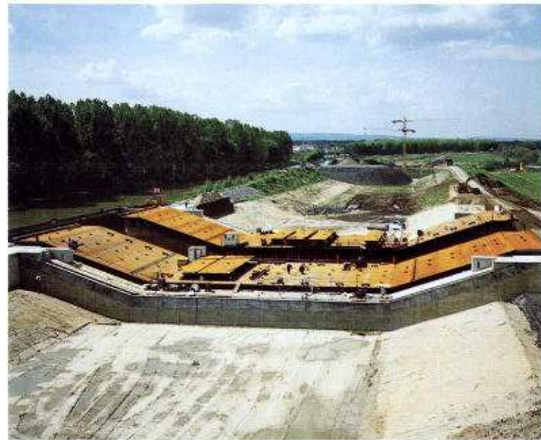
Montage der Stahlteile an der Br. 253
