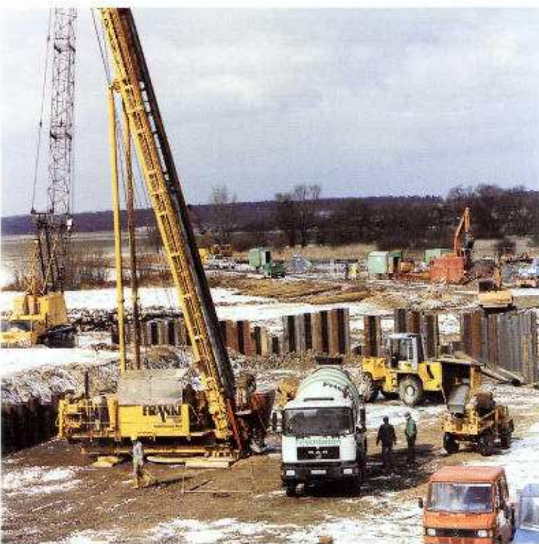
Herstellung der Ortbetonrammpfähle
