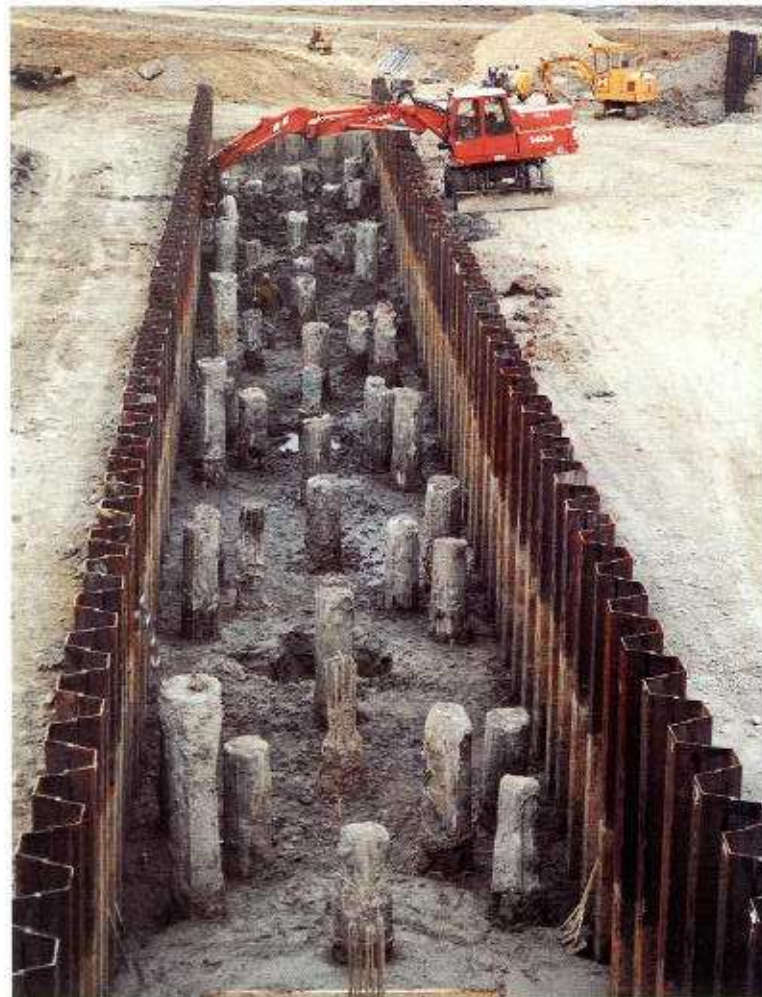
Umspundetes Pfeilerfundament der Flutbrücke
