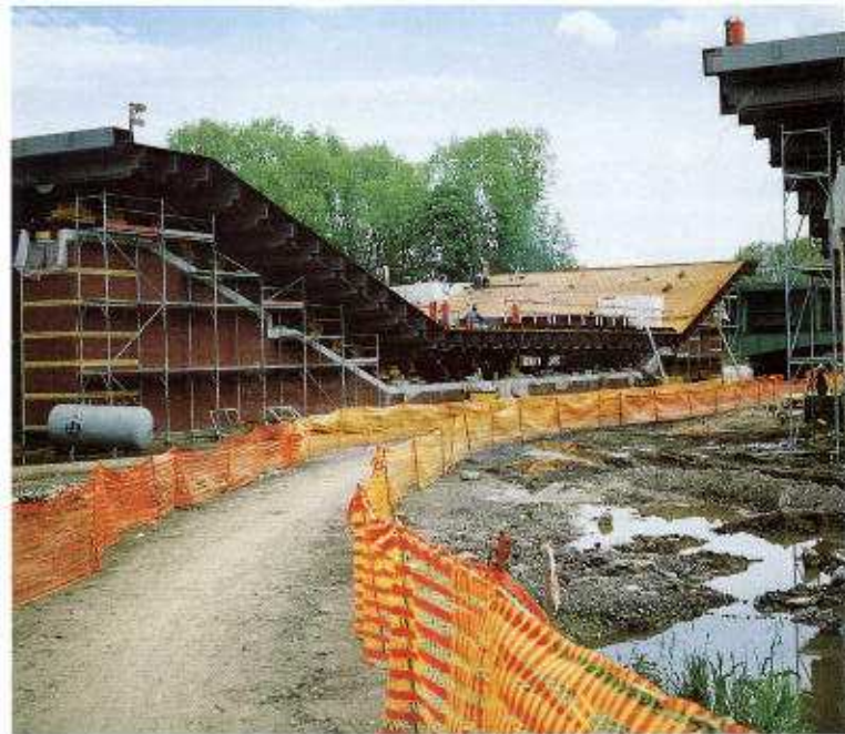
Unterführung des Radfernwanderweges, Baufeld Br. 253
