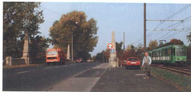
Die Tage der alten Überführung am Großen Kolonnenweg sind gezählt. Brücken Nr. 230 und 230 A
