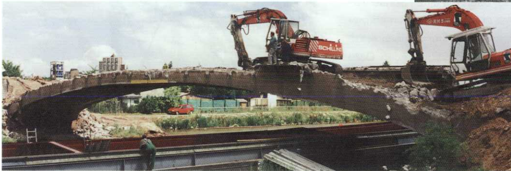
Abriß der alten Brücke Nr. 232
