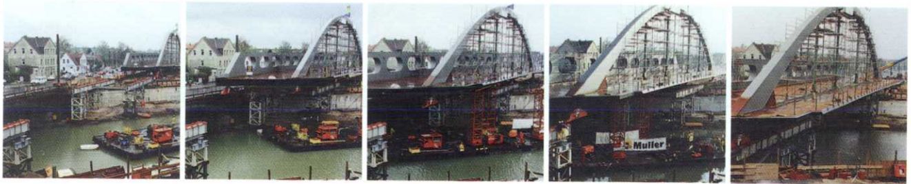
Die Bildreihe dokumentiert den Einschub der Brücke 237 (westliches Segment) an der Podbielskistraße im April 1998
