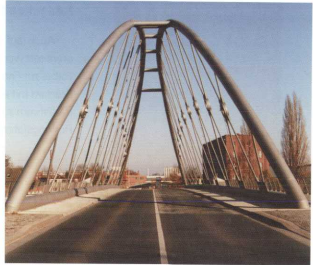
Beneckeallee – Brücke Nr. 226
