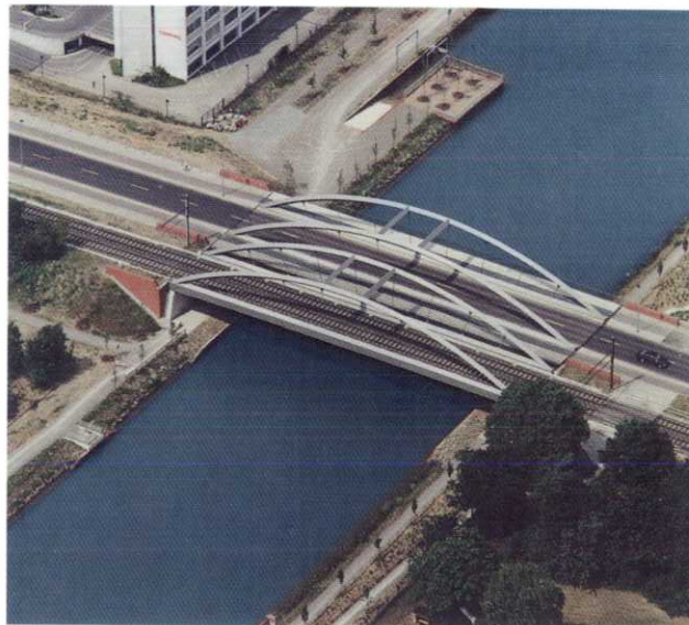
Großer Kolonnenweg Brücken Nr. 230 und 230 A kurz nach der Fertigstellung
