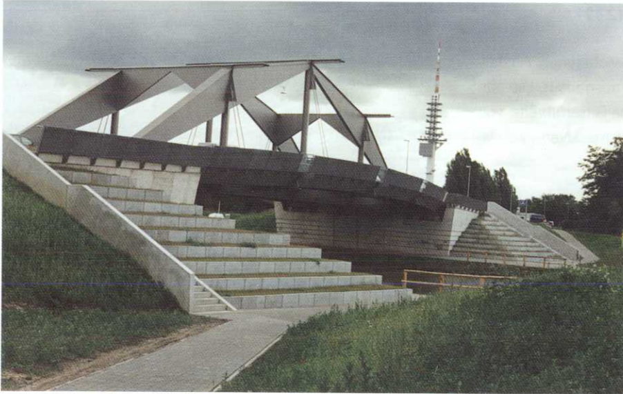
Eulenkamp – Brücke Nr. 236: Das nicht alltägliche Erscheinungsbild der Konstruktion wird die Diskussion um die Gestaltung von Brücken sicher beleben.
