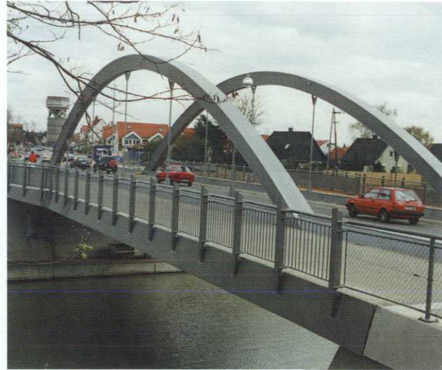
Brücke Nr. 241 – Hannoversche Straße
