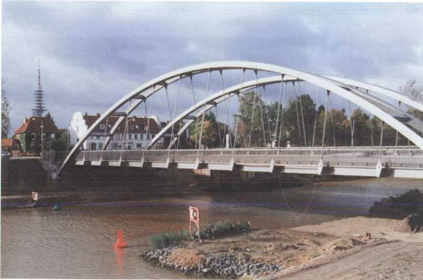
Pasterallee Brücke Nr. 239
