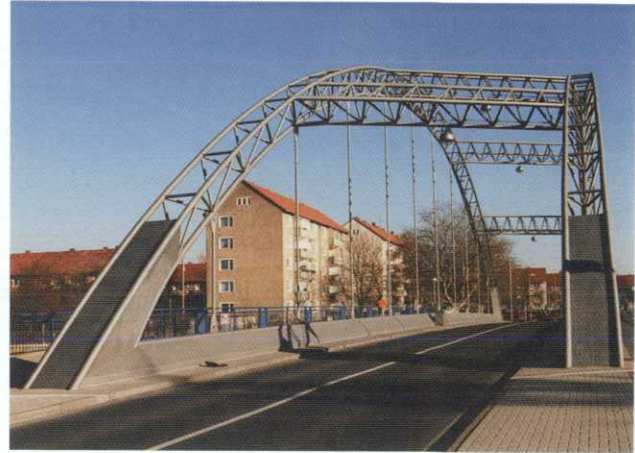
Brücke Nr. 240 – Schierholzstraße
